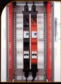
**ELEMENTOS MAGNETOTÉRMICOS:** Elementos de protección integrados en el módulo de interconexión. Equipamiento opcional.
