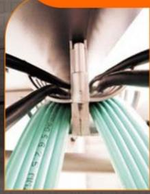
**DOBLE CANAL:** Permite separar alimentación eléctrica de voz y datos.
